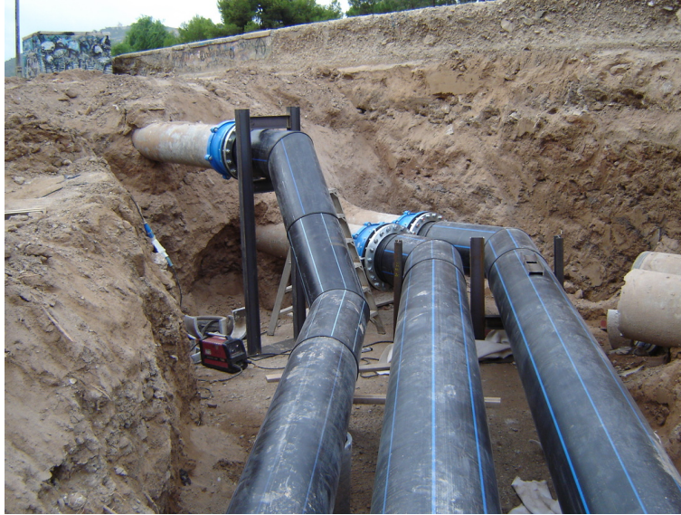
Figure 6: Aumento de la capacidad de un acueducto veredal mediante la construcción de una tercera tubería.
